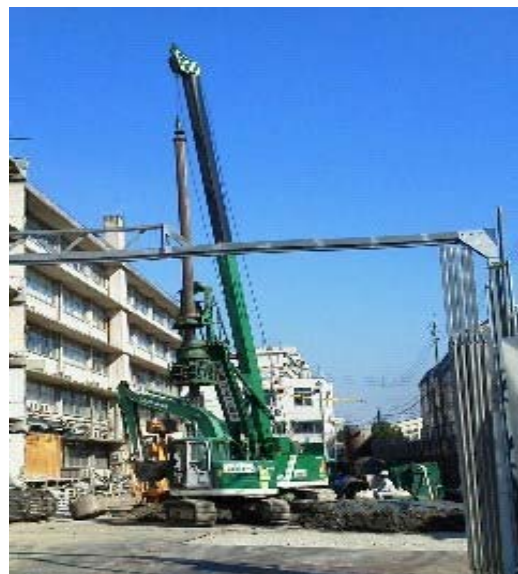
新病院建て替え工事をすすめる済生会病院（西区）
